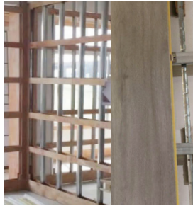
(龙骨+夹板条) Steel Keel+Studs
